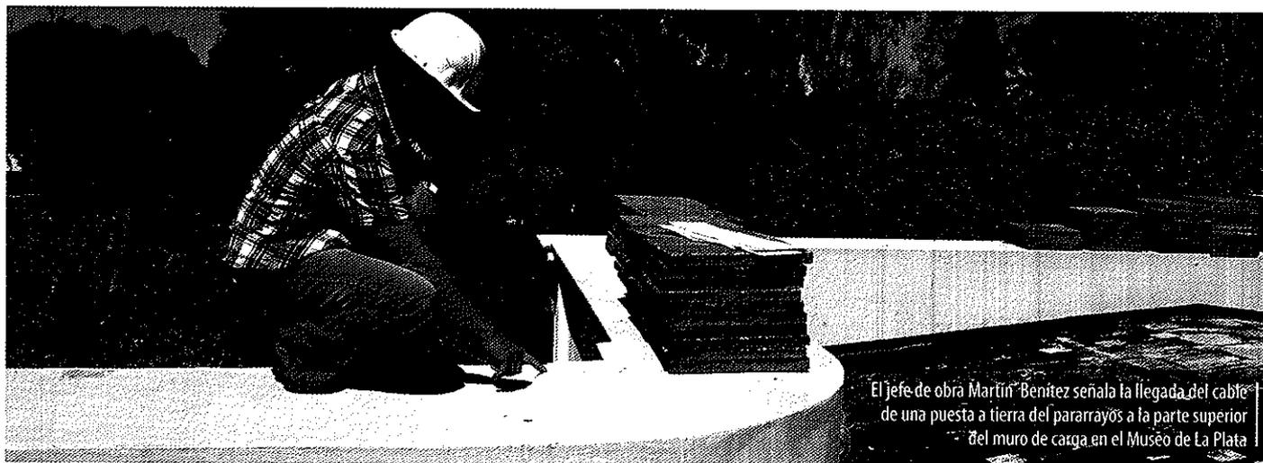
El jefe de obra Martín Benítez señala la llegada del cable de una puesta a tierra del pararrayos a la parte superior del muro de carga en el Museo de La Plata
